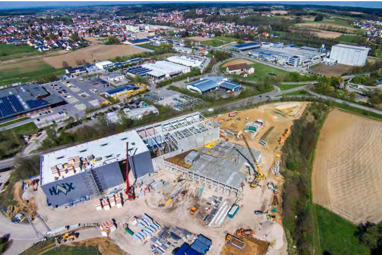
HAIX-Baustelle aus der Drohnenperspektive / From high above
